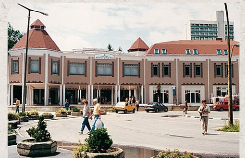
Aparthotel Hévíz MAĎARSKO / štúdio 3 lôžka
